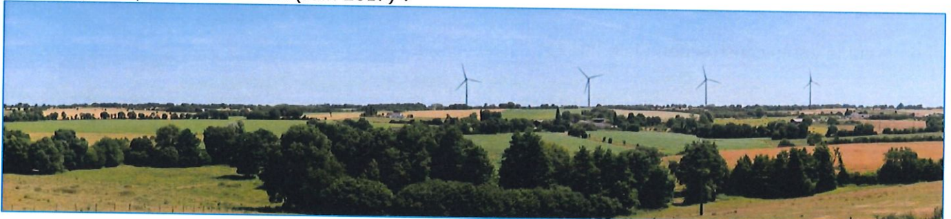
Photographie après construction (Juin 2017) :
