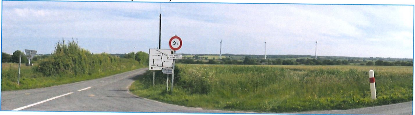
Photographie après construction (Mai 2016) :
